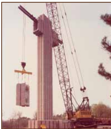
La construction de la croix de Lorraine. © Mémorial Charles de Gaulle
